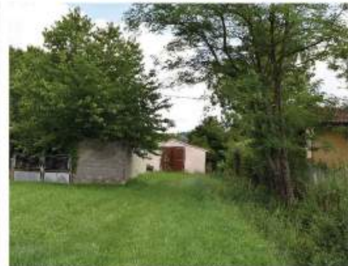
Des constructions de fond de parcelles qui bloquent le chemin
