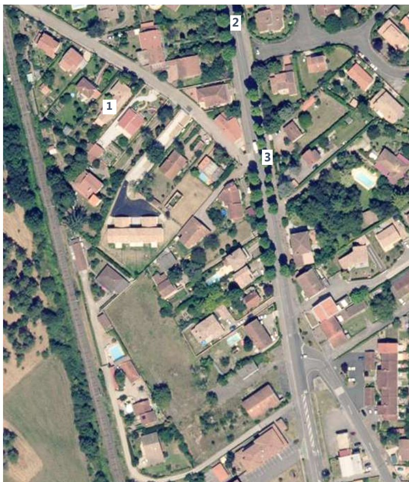
Figure 67 : Illustration de l'urbanisation linéaire : rue de la Résistance et rue d'Andorre Source : Google Satellite et photos Puva
